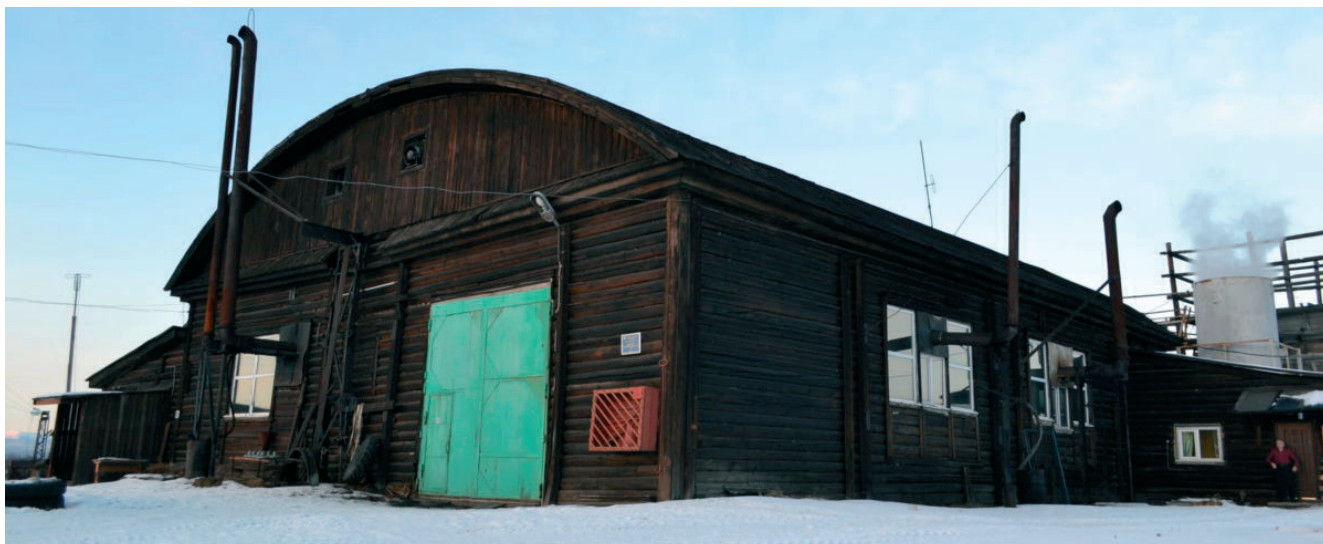
Рисунок 2.22 – здание дизельной электростанции «ДЭС-16»
