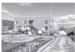
📷 Ремонт детсада в п. Ключи / ФОТО «УКВ»
