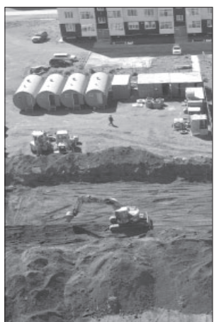
Строительная площадка, п. Усть-Камчатск / ФОТО «УКВ»
