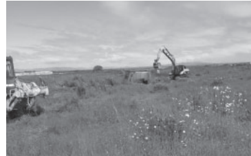
● Уборка строительного мусора / ФОТО «УКВ»
