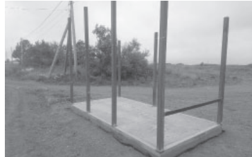
● Фундамент под новый автобусный павильон / ФОТО «УКВ»
