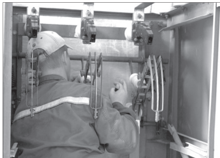
Ремонт электрооборудования в ТП-57 / ФОТО «УКВ»
